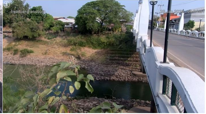
C031703 : สะพานห้วยหลวงอนุสรณ์ ต.จุมพล อ.โพนพิสัย จ.หนองคาย
